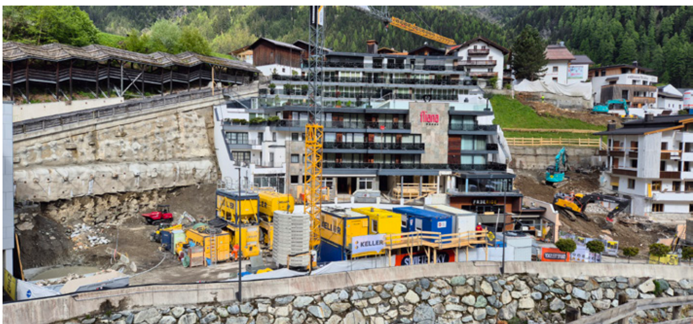
Baustelleneinrichtung Hotel Fliana Ischgl
