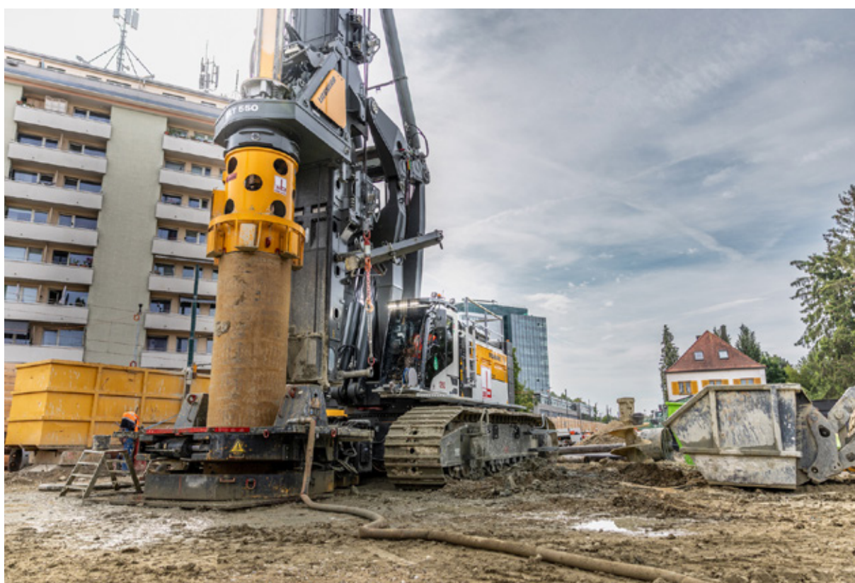
Das Bohrgerät LB 55 überzeugt bei Bohrpfählen mit großen Durchmessern.
