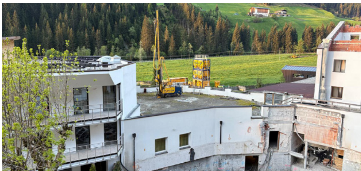
KB0-5 Am Dach des Alphotel Tyrol in Ratschings
