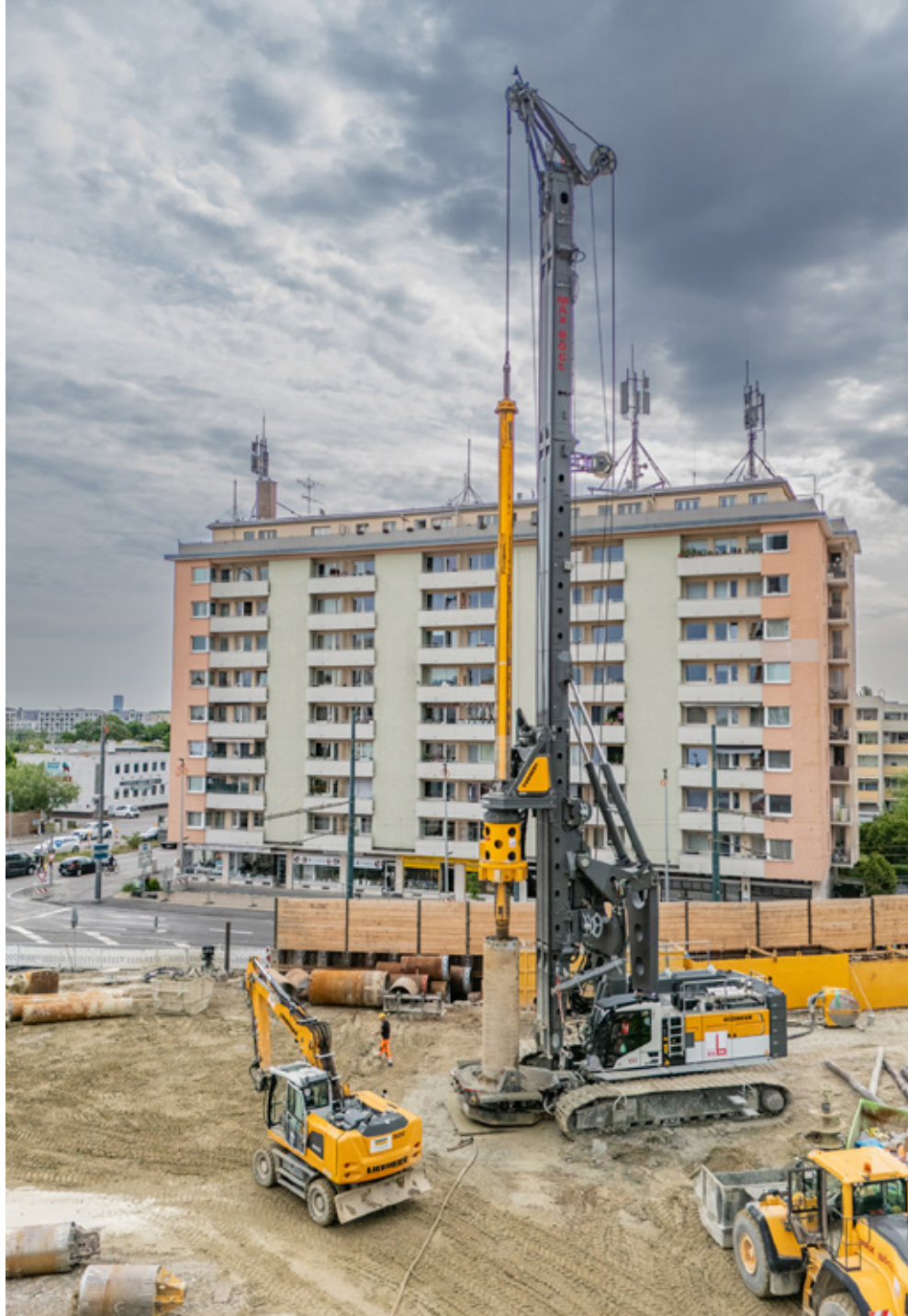
Das LB 55 bei der Erweiterung der U-Bahnlinie U5 in der Münchner Innenstadt.
